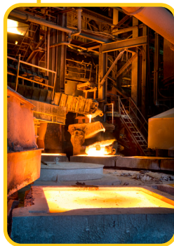
پروژه احداث کوره آند
