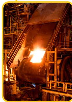
پروژه انتقال گازهای خروجی از کنورتور
