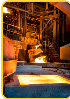
پروژه احداث کوره آند
