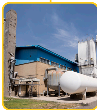
مشاوره و نظارت بر احداث کارخانه تولید اکسیژن سرچشمه
