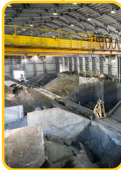
پروژه احداث انبار کنسانتره
