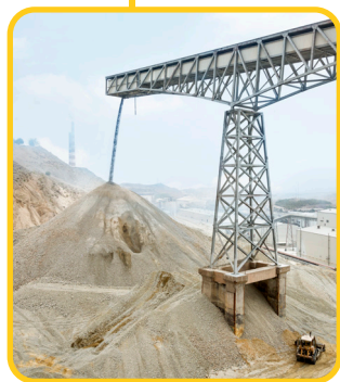
پروژه اجرای پایه‌های بتنی و سازه فلزی نوار نقاله شماره ۲
